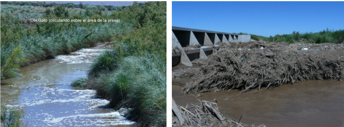
Figura 8: Estado de los arroyos del Gato (izquierda) y Santa Catalina (derecha) en su ingreso a la presa del Tigre Muerto (año 2009). En el primero se observa el curso de agua circulando sobre el área de la presa; en el otro la acumulación de sedimentos.
